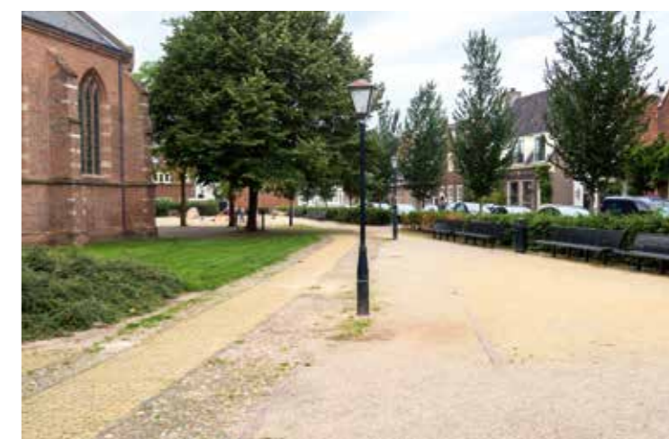
Aan de noordwestkant is een jeu-de-boulesbaan aangelegd. De afmetingen van de baan zijn gemarkeerd met een dubbele klinkerrand in een halfverharding van Stabilizer. Deze subtiele markering zorgt ervoor dat ook zonder dat er gespeeld wordt, het plein er mooi uitziet, aldus Hanneke Toes.
